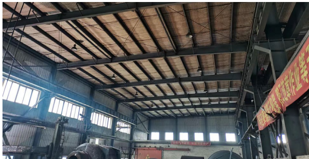
照片 14 探伤室顶棚
