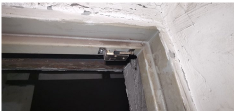
照片 4 操作门门机联锁
